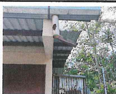
Foto 4: Sustitución de lámina
