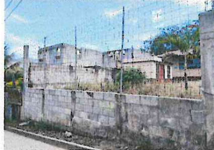
Foto 2: Reparación de muro perimetral de block
